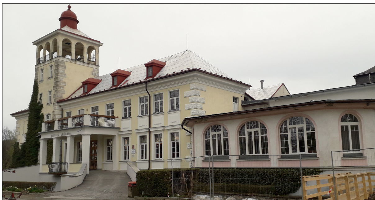
Obrázek č.1. Sanatorium Edel s.r.o., Zlaté hory.
