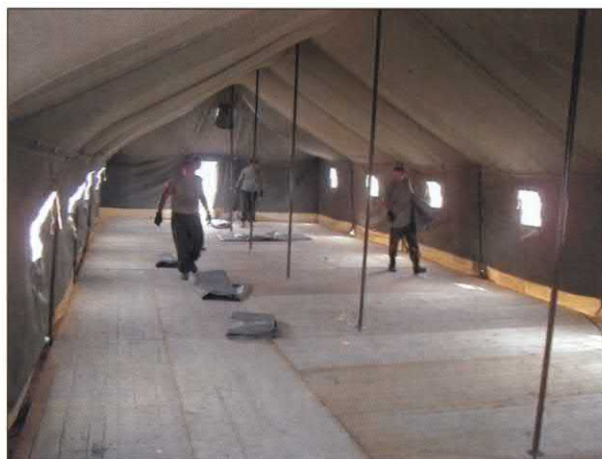
Obr. VI: Stavba hlavní chodby nemocnice
