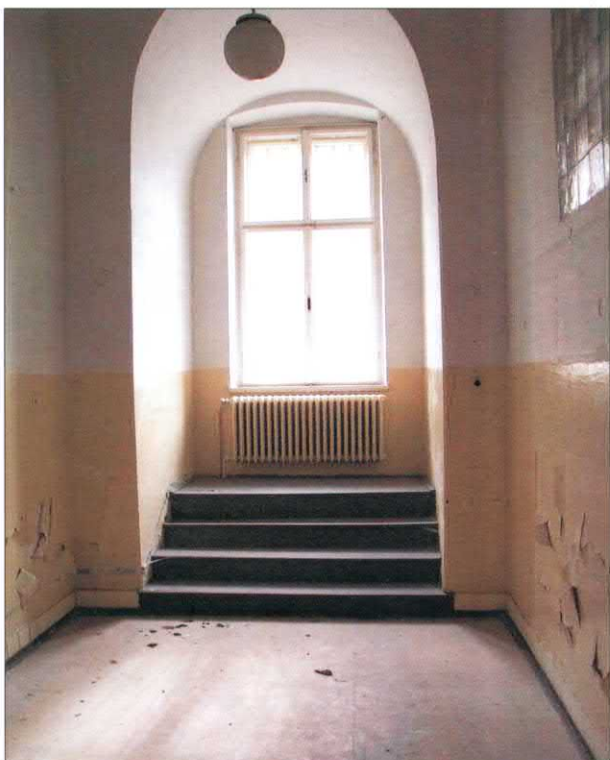
Obr. 7: Prostory bývalé pracovny velitele nemocnice
