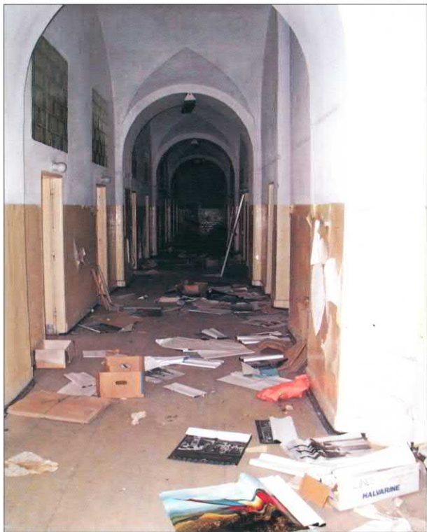
Obr. 9: Jedna z chodeb nemocnice po odchodu Sovětské armády
