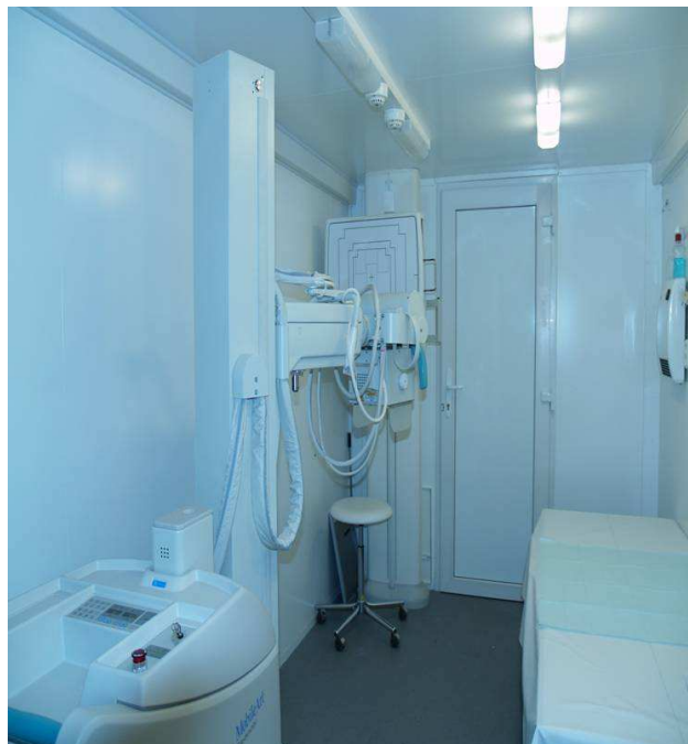
Obr. 7: Samostatné pracoviště radiodiagnostiky
